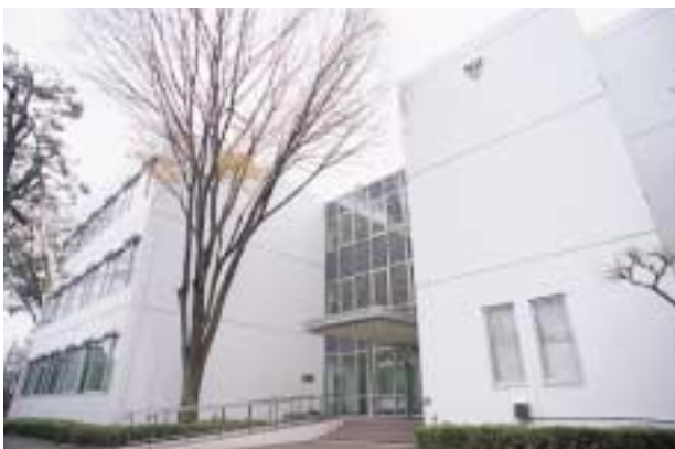
和泉短期大学校舎正面玄関
